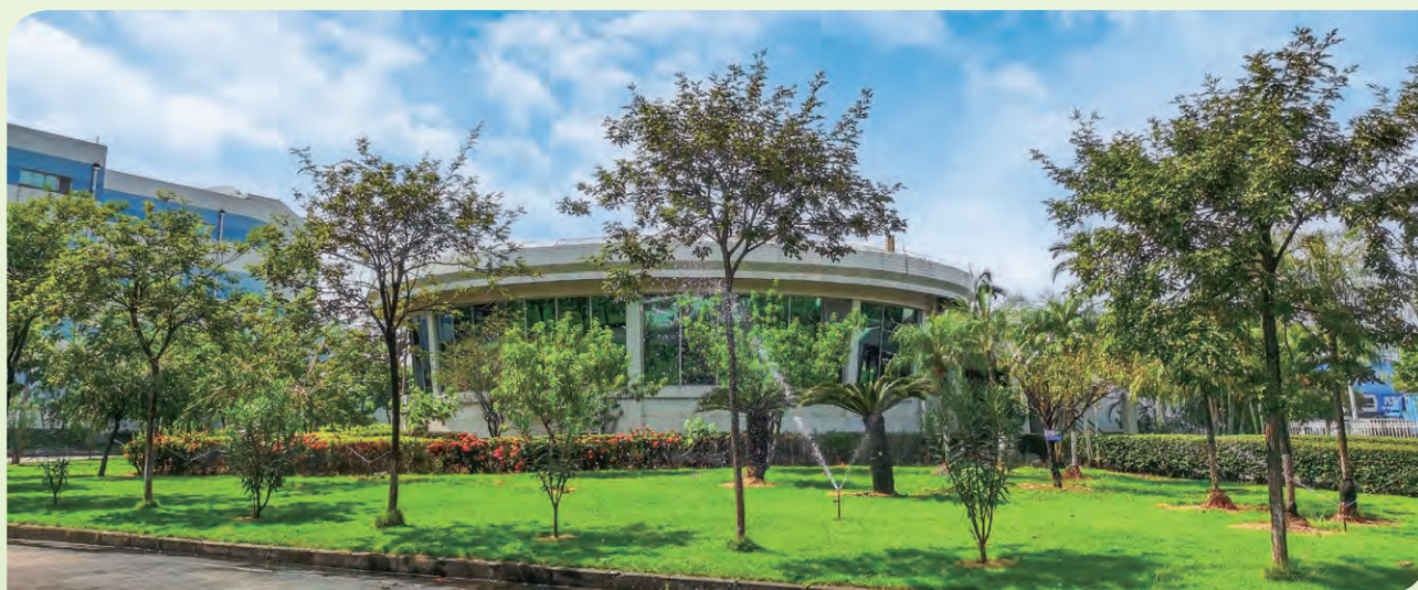
位於偉易達工廠的雨水收集系統
